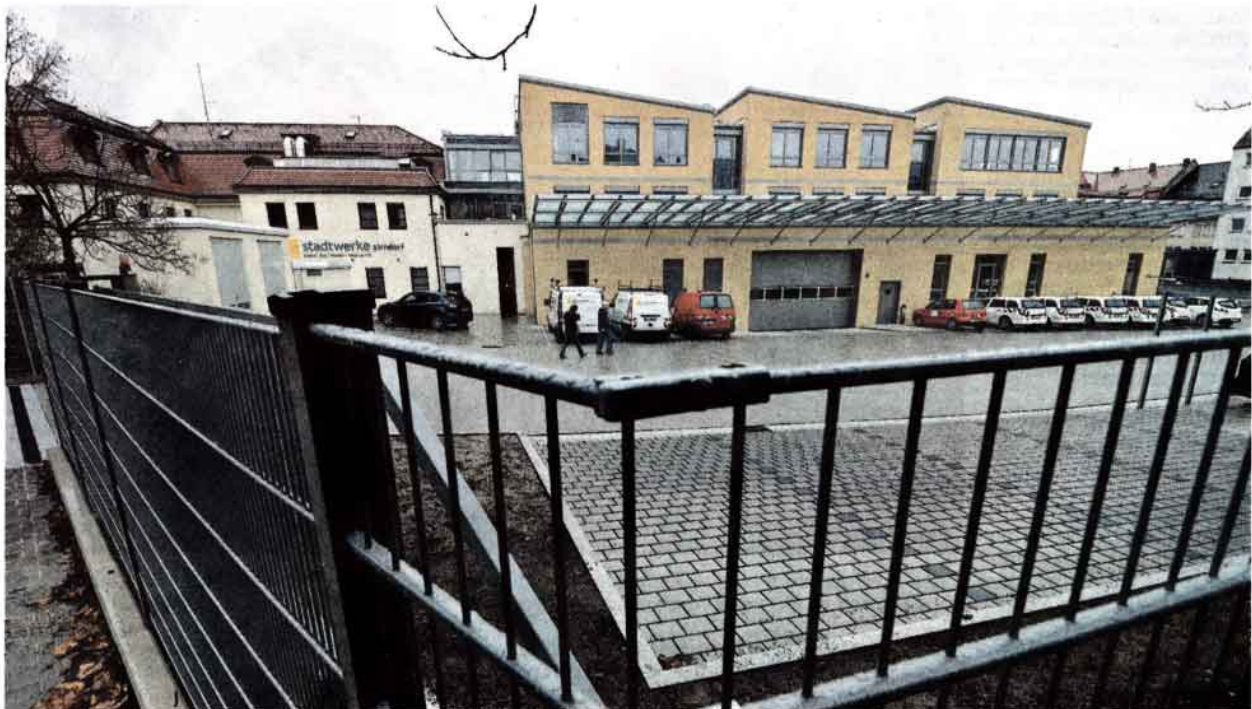
Mehr Platz für die Zirndorfer Stadtwerke: In dem Erweiterungsbau sind eine Fahrzeughalle und Büros untergebracht, und das alles in bester innerstädtischer Lage. Foto: Horst Linke
